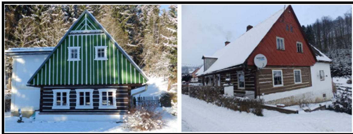
Obr. 6 – Rekonstrukce chalupnických stavení (Vlevo rekonstrukce respektující tradiční materiály i prvky. Vpravo je pak použit moderní materiál, plast.)
