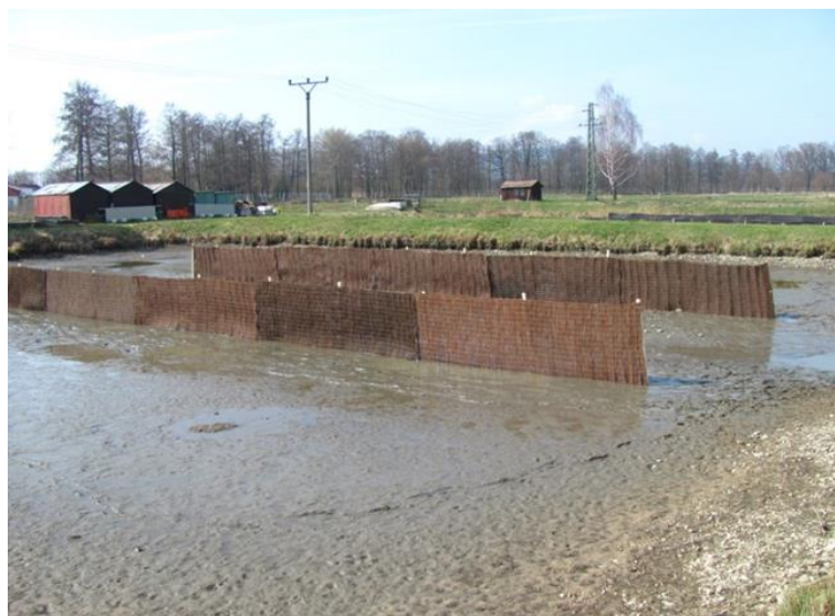
Obr. 1: Rohože z vřesovce, instalované ve vypuštěném rybníce na pokusnictví VÚRH Vodňany (foto: Bláha, 2014).
