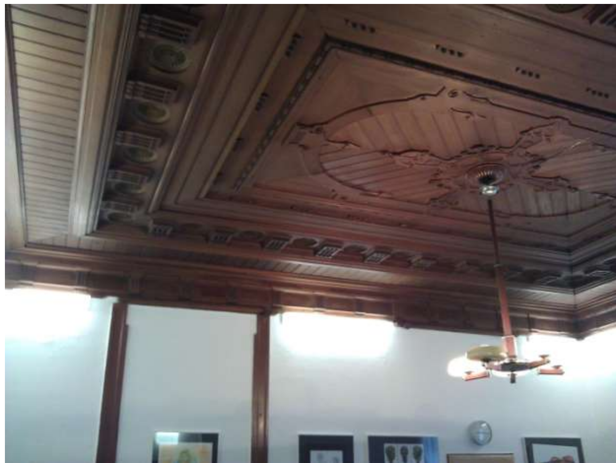
Salon - strop, na zdi pozůstatek obložek dveří do zimní zahrady
