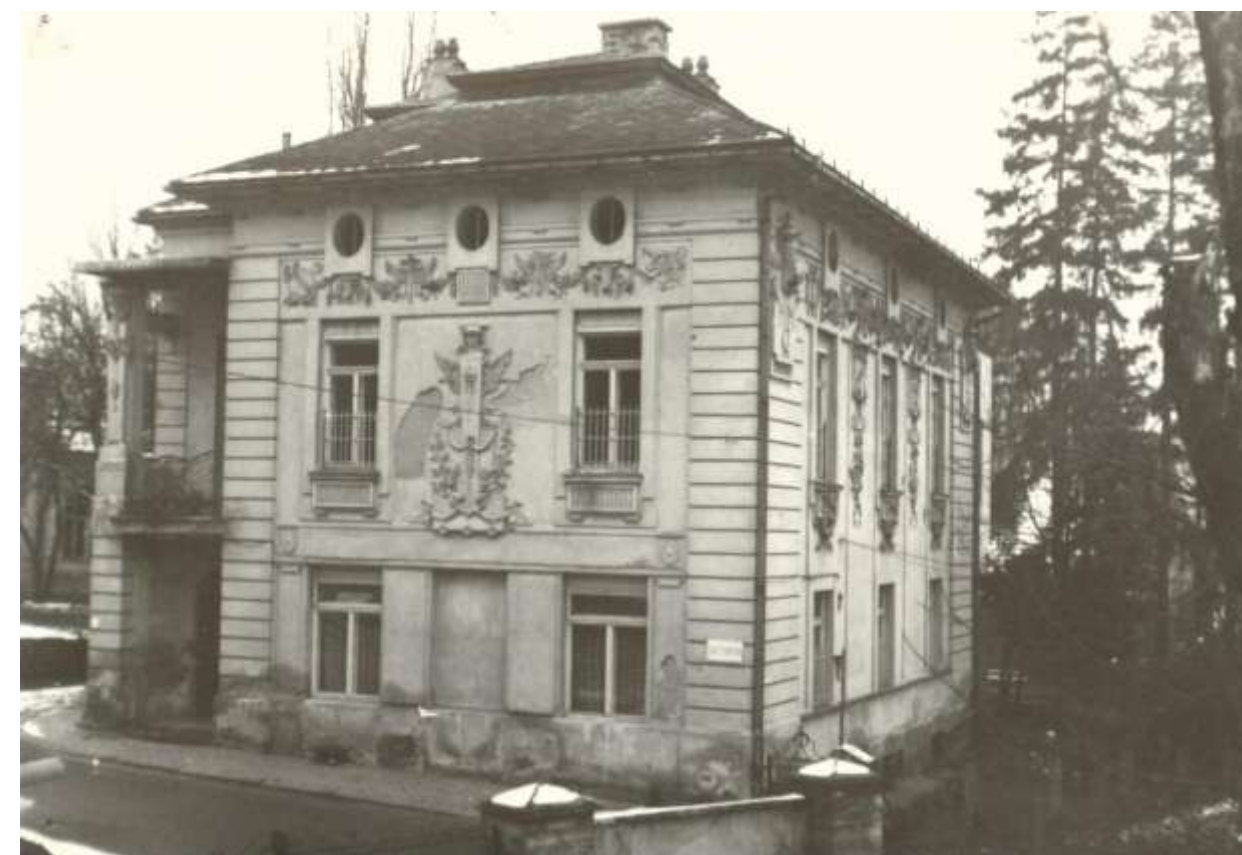
Jasně viditelný objem nové přístavby. Datace cca 70. léta, před opravou fasády.
