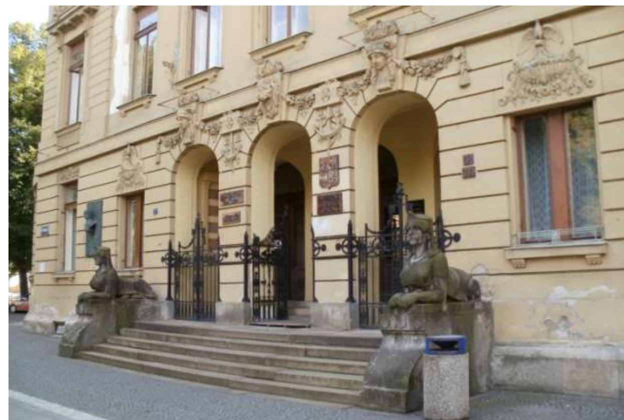
č.p. 331, Hradec Králové - detail vstupu
