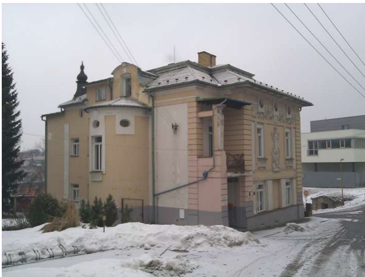
Vzhled stavby před obnovou střechy (fotografováno 2012)
