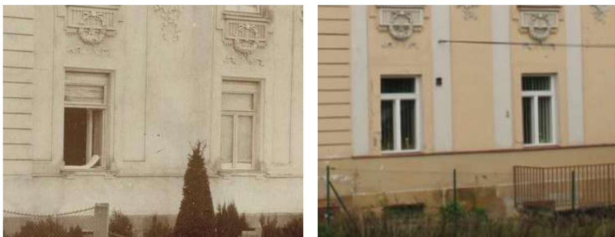
Porovnání stavu po dokončení objektu a stávajícího stavu - úprava soklu a okenních otvorů v 1.NP
