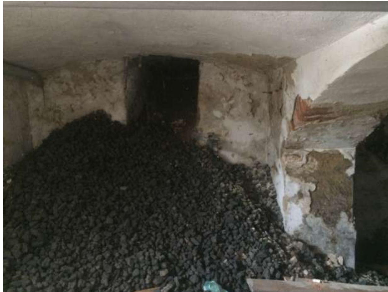
Bývalá uhelna - kamenné obvodové zdivo, klenuté stropy
