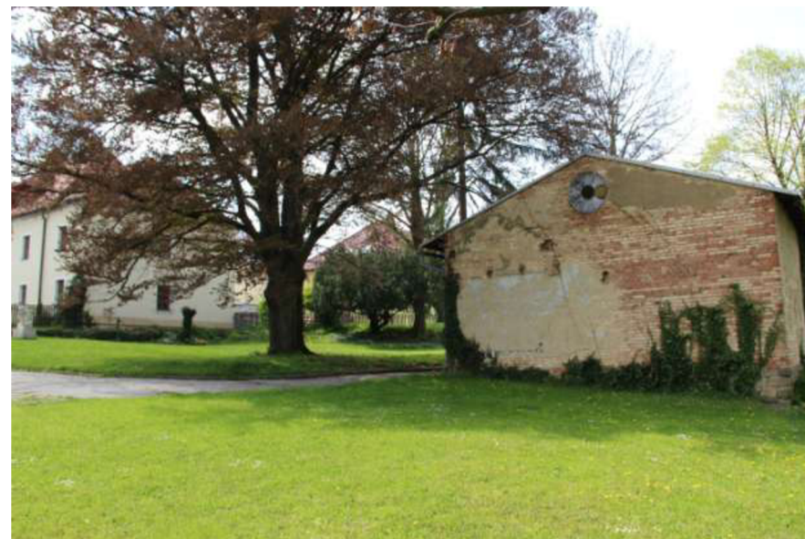
Zahradní sklad s otiskem domku, pozůstatkem vnitřních omítek a kapsami od zasekaných trámů. V pozadí vzrostlý červenolistý buk, který bude ponechán i v návrhu.
