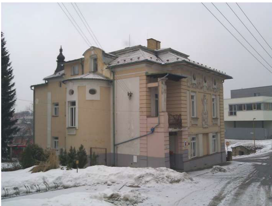
Vzhled stavby před obnovou střechy (fotografováno 2012)
