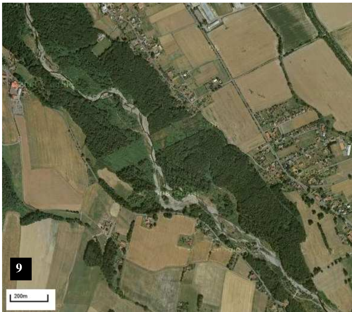
Obrázek 9. Morávka - nezregulované koryto řeky mezi Nižními Lhotami a Skalicí.
