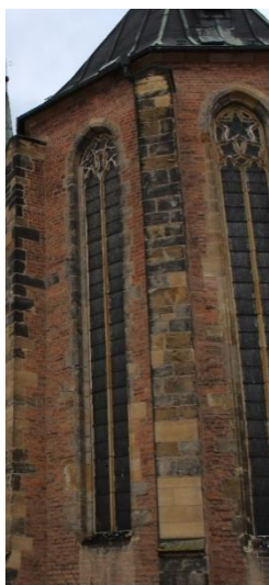
[6] Kružba (3. pole uprostřed) složená z hvězdy a dvou sférických čtyřúhelníků na presbytáři kostela sv. Jiljí v Nymburce. Po pravé i levé straně od středu jsou kružby stejné se změnou v zakončení dvou pásů sdruženého okna, které je trojlísté – závěr kostela konec 13. století, kružby K. Hilbert 1916.
