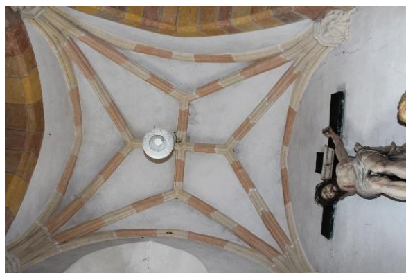
[16] Přizemí jižní věže sv. Jiljí v Nymburce s jedním klenebním polem hvězdového žebrového stylu.
