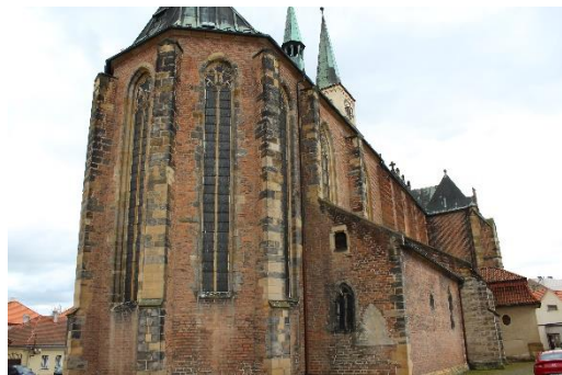
[6] Kružba (3. pole uprostřed) složená z hvězdy a dvou sférických čtyřúhelníků na presbytáři kostela sv. Jiljí v Nymburce. Po pravé i levé straně od středu jsou kružby stejné se změnou v zakončení dvou pásů sdruženého okna, které je trojlísté – závěr kostela konec 13. století, kružby K. Hilbert 1916.
