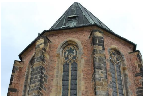
[6] Kružba (3. pole uprostřed) složená z hvězdy a dvou sférických čtyřúhelníků na presbytáři kostela sv. Jiljí v Nymburce. Po pravé i levé straně od středu jsou kružby stejné se změnou v zakončení dvou pásů sdruženého okna, které je trojlísté – závěr kostela konec 13. století, kružby K. Hilbert 1916.
