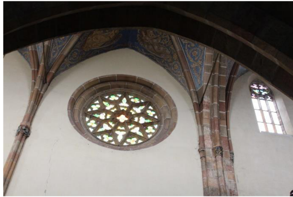
[7] Rozetové okno na jižní stěně hlavní lodi kostela sv. Jiljí v Nymburce – kružba K. Hilbert 1916.
