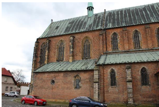
[3] Severní loď kostela sv. Jiljí v Nymburce s opěráky.
