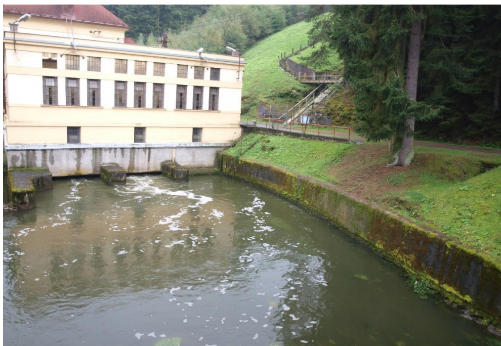
Obr.11 Malá vodní elektrárna na VD Sedlice
