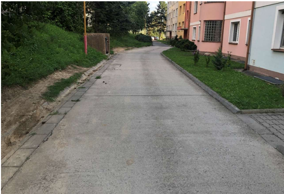
Obrázek 6: Komunikace 05 – Cementobetonový kryt části vozovky
