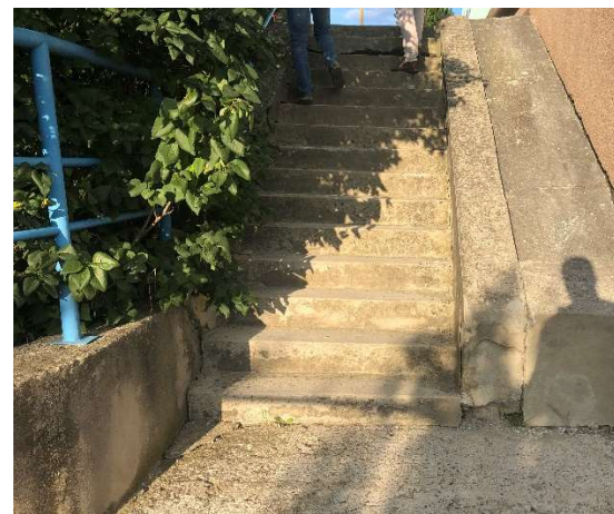
Obrázek 9: Schodiště – trhlina
