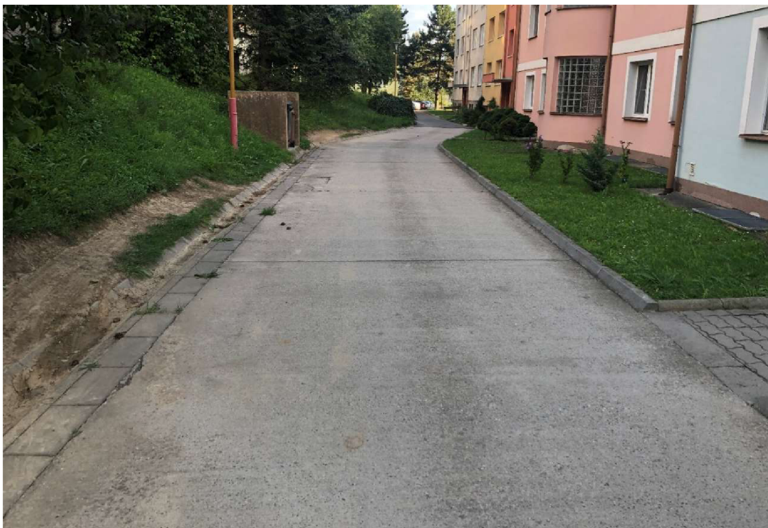
Obrázek 6: Komunikace 05 – Cementobetonový kryt části vozovky
