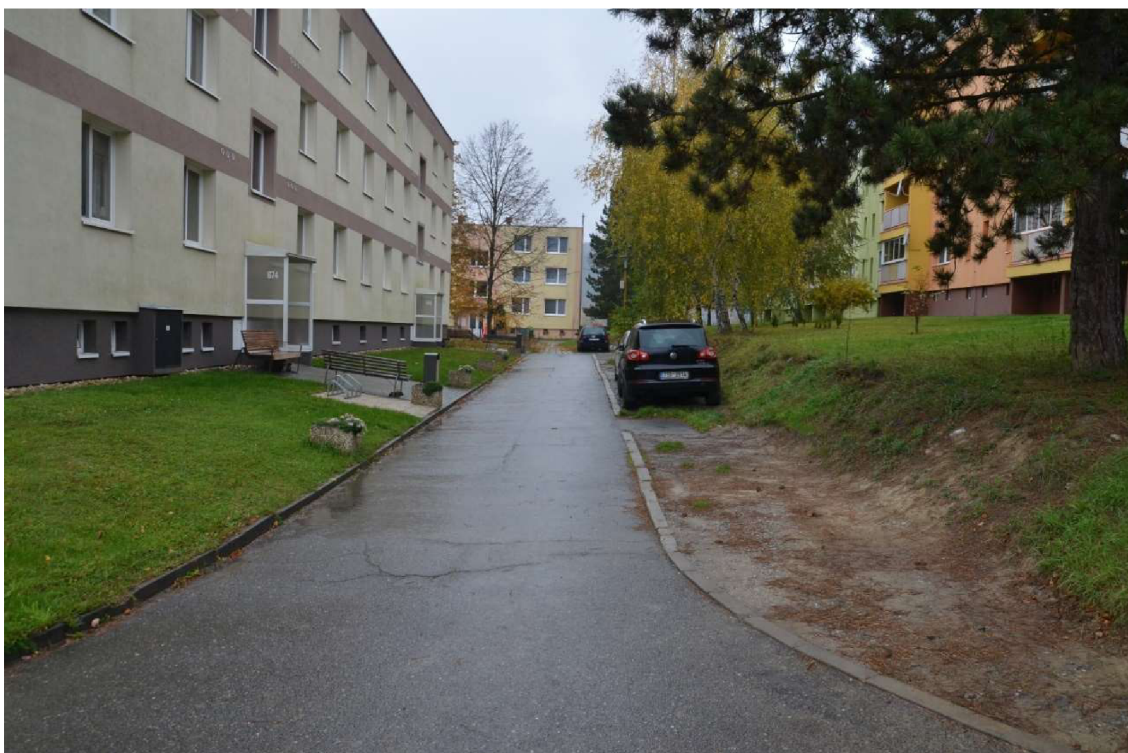
Obrázek 3: Komunikace 02 – příčné trhliny
