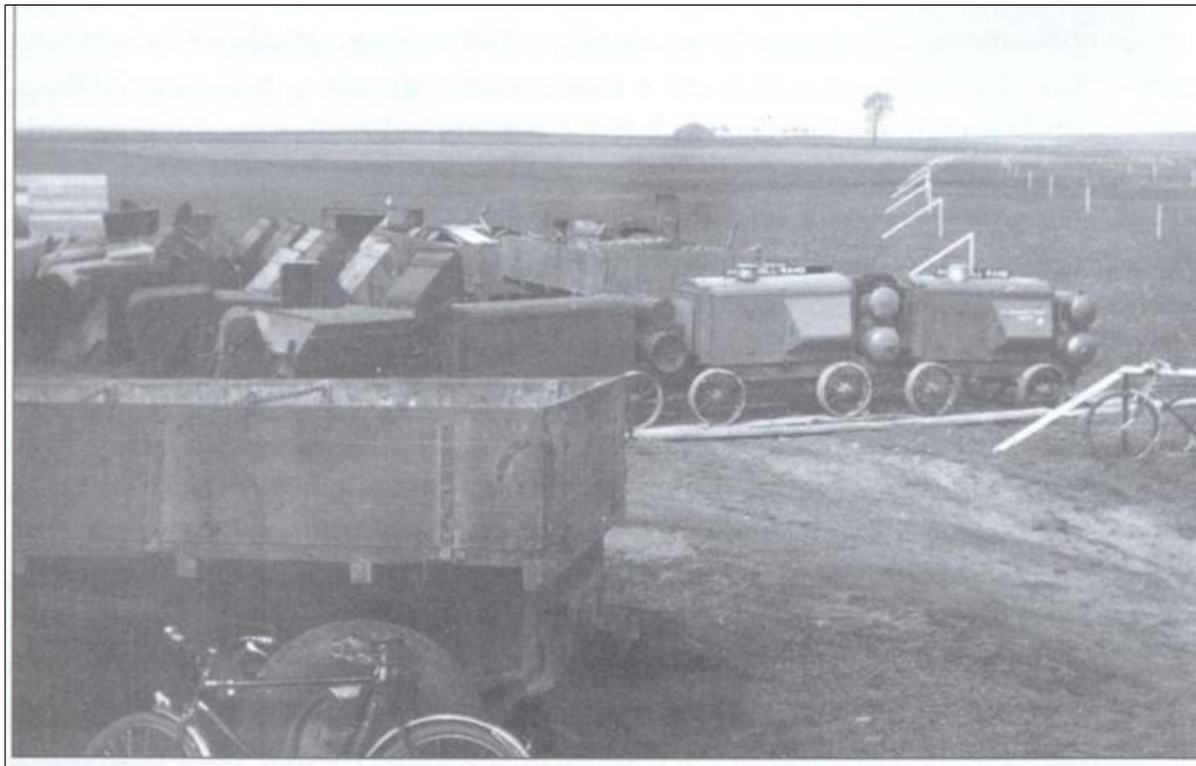
Obr. č. 70. Výstavba dálnice z let 1938-1940. Zdroj: MÚ Praha 11
