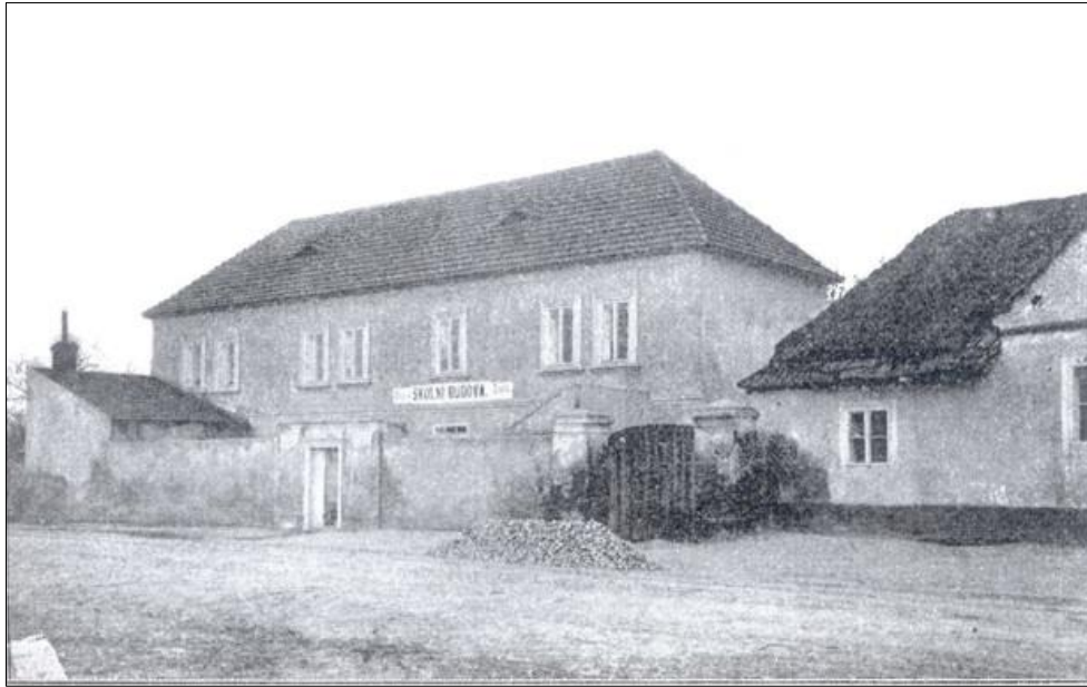
Obr. č. 32. Původní zaniklá školní budova. Nová škola v roce 2015.
