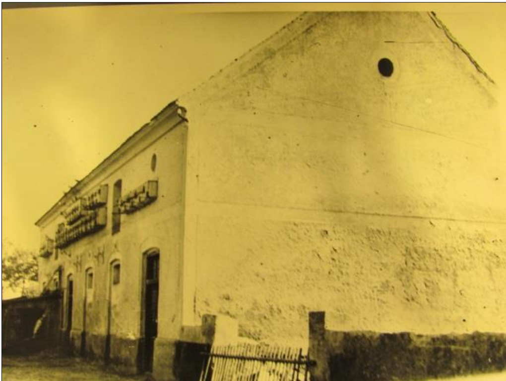
Obr. č. 7. Chodovský dvůr v roce 1927. Zdroj: Archiv hl.m.Prahy
