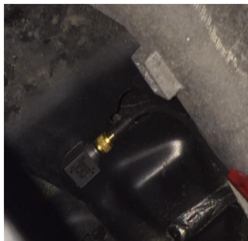
Obr. 66c Umístění akcelerometru T4
