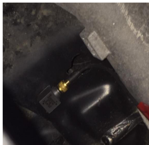
Obr. 66c Umístění akcelerometru T4
