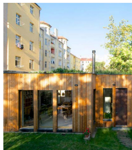
obr. 16 Mokřadní střecha v Praze (Pražanová 2017)
