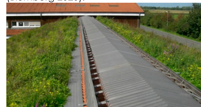
obr. 20 Mokřadní střecha kravína (Zehnsdorf et al. 2019)
