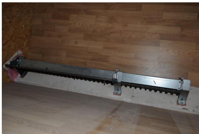
Obr. 7 Závitový dopravník v sklade peliet
