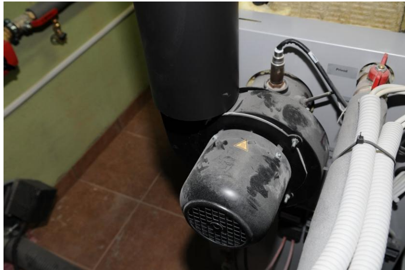
Obr. 16 Lambda sonda a spalínový ventilátor
