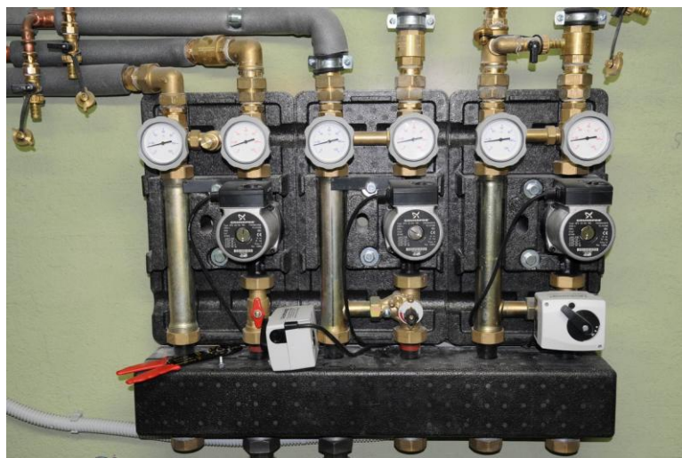
Obr. 23 Rozdeľovač s tromi čerpadlovými skupinami
