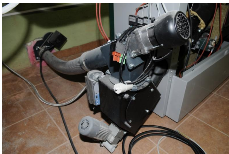
Obr. 8 Dopravný systém kotla s pohonom a RSE klapka
