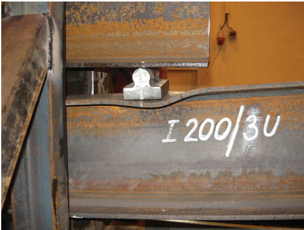
Obr. 13.2 Detailní zobrazení kontaktního místa mezi roznášecí konstrukcí a ověřovaným nosníkem přes roznášecí segment. Nosník je zobrazen po překročení únosnosti. V místě působení síly je patná deformace horní pásnice.
