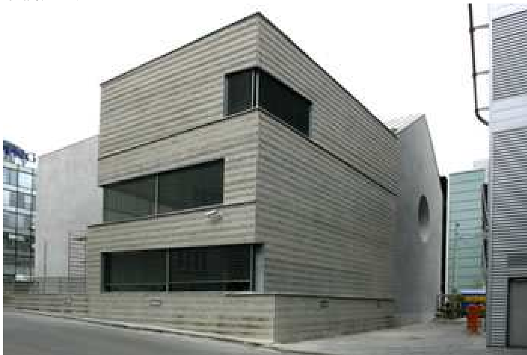
Přístavba smíchovské synagogy z roku 2002
