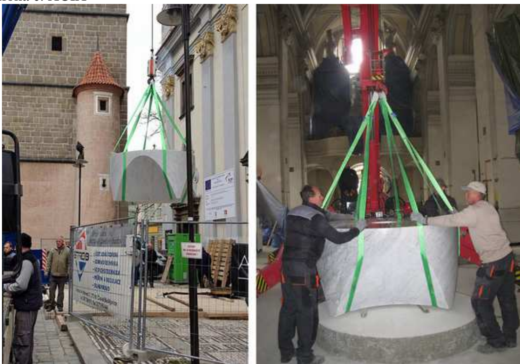
Instalace nového oltáře do katedrály
