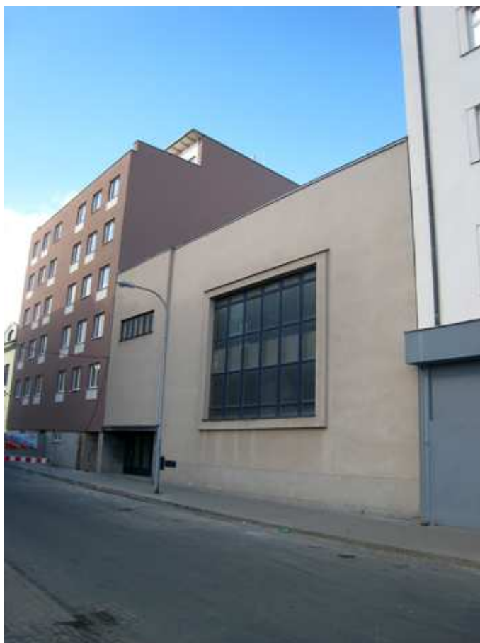
Synagoga Agudas achim – Brno
