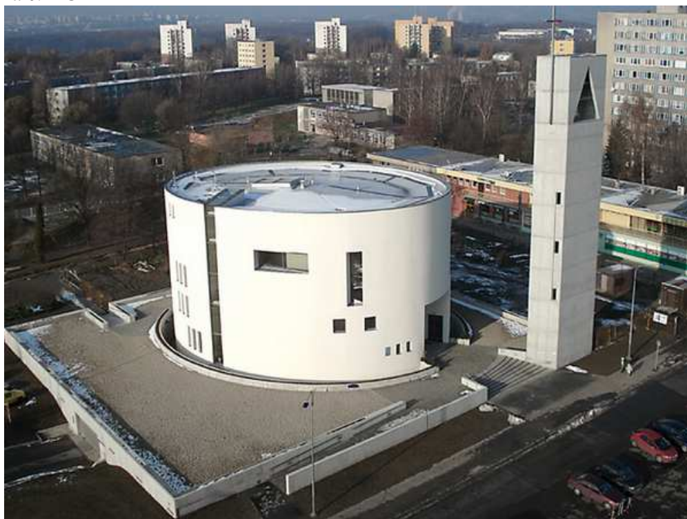
Kostel sv. Ducha – Ostrava-Zábřeh
