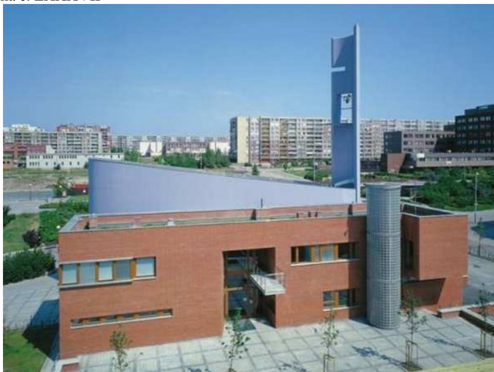
Kaple a komunitní centrum sv. Prokopa – Praha-Nové Butovice
