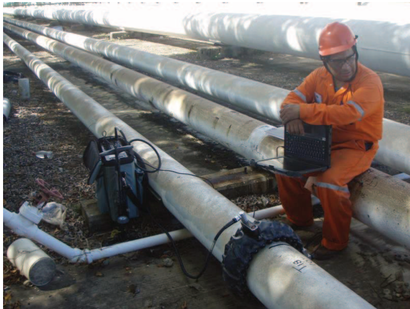
Obrázek 22 - Kontrola potrubí metodou guided waves
