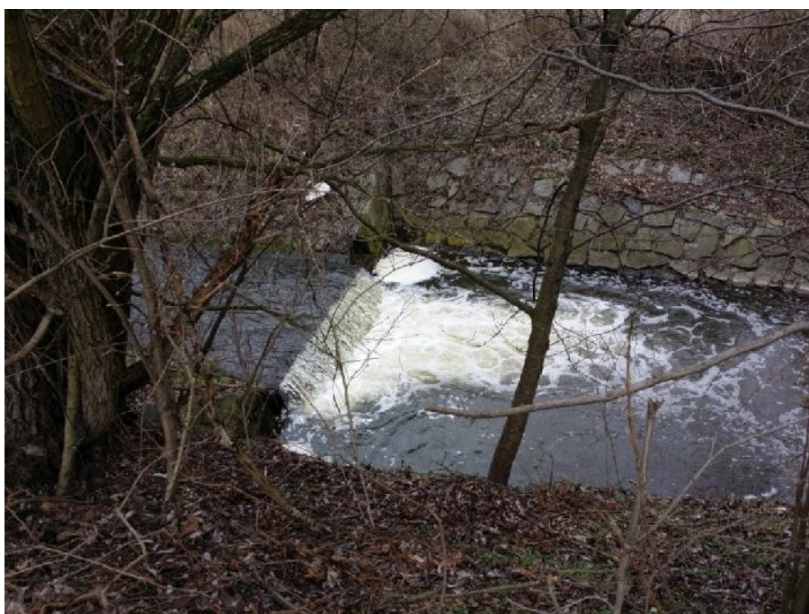
Foto. č. 4: Stupeň na vodním toku nacházející se zhruba v polovině délky pozemku (autor práce, 2017)
