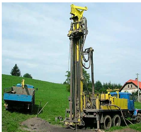
Obr. č. 8 – Vrtná souprava: Mobile Drill 80 29)
