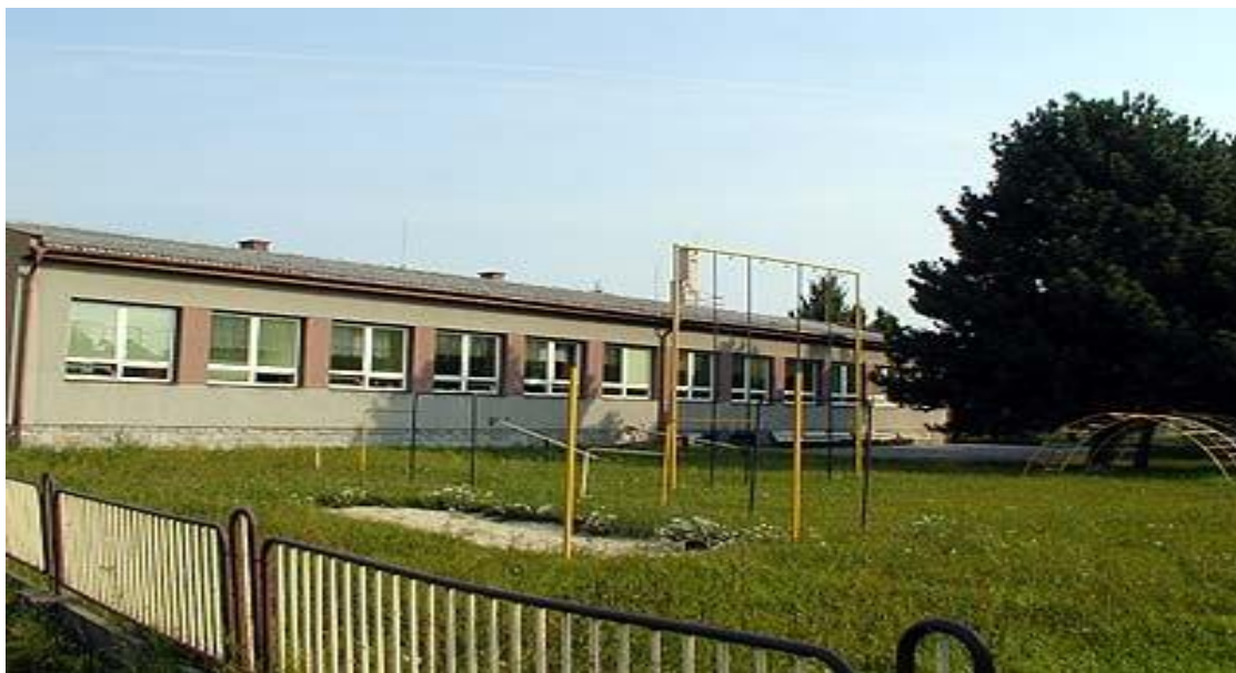
Obrázek 7: Snímek základní školy před rekonstrukcí
