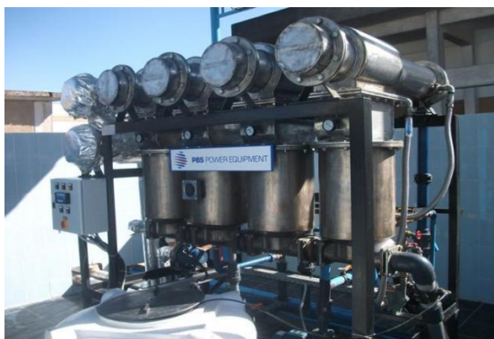
a) po kompletní instalaci
