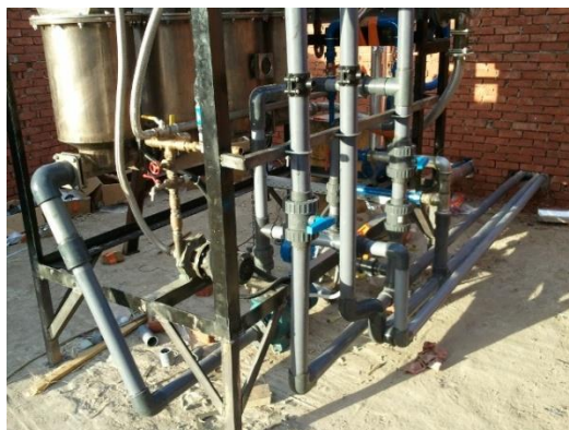
b) průběh instalace
