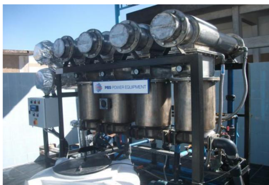
a) po kompletní instalaci
