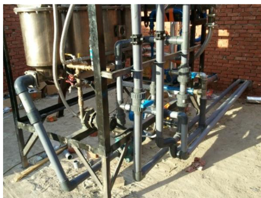
b) průběh instalace
