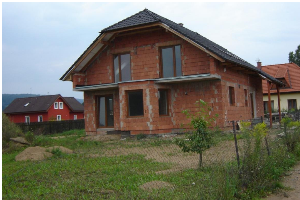
Obr. 1 Rodinný dům v Černošicích před zateplením fasády
