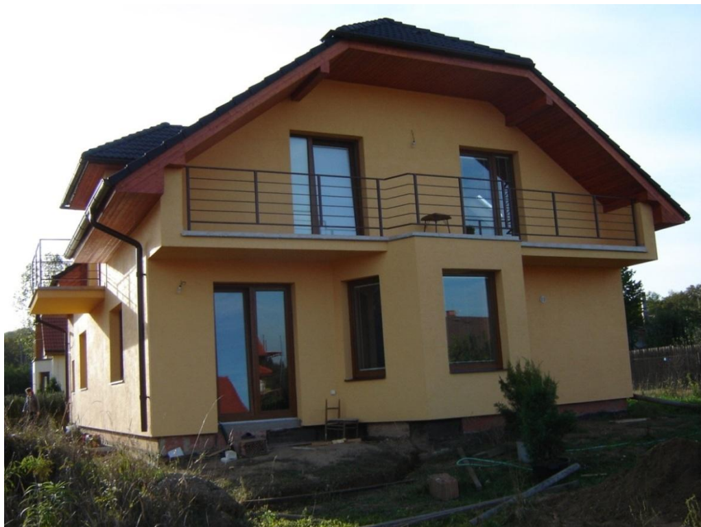
Obr. 4 Rodinný dům v Černošicích po zateplení fasády
