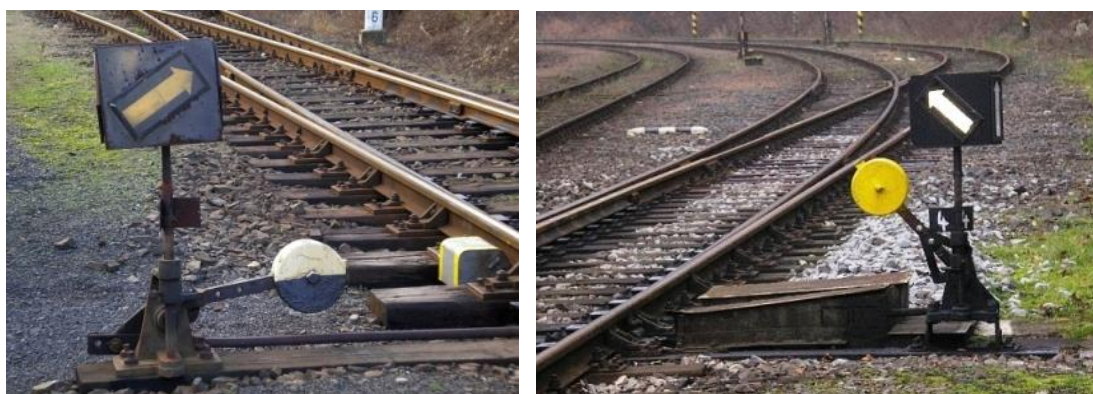
Obr. 5: Ručně a ústředně stavěná výhybka
