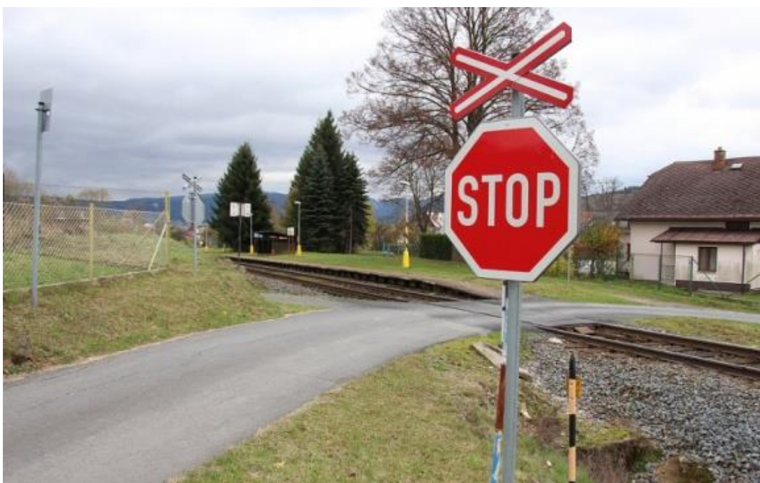
Obr. 18: Nezabezpečený přejezd doplněn dopravní značkou P6 – Stůj, dej přednost v jíždě! Zdroj: Krňávek (2017), vlastní úprava
