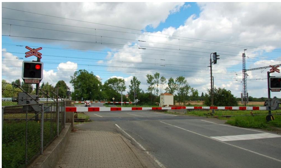
Obr. 14: Plně zabezpečený uzavřený vícekolejný železniční přejezd vykazující výstražný signál
