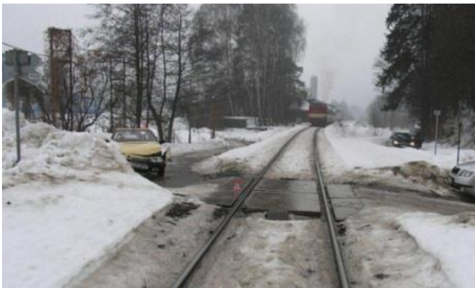
Obr. 51: Kupy sněhu na nezabezpečeném přejezdu brání ve výhledu
