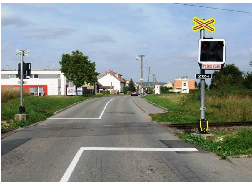
Obr. 16: Zabezpečený otevřený jednokolejný železniční přejezd vykazující varovný signál
