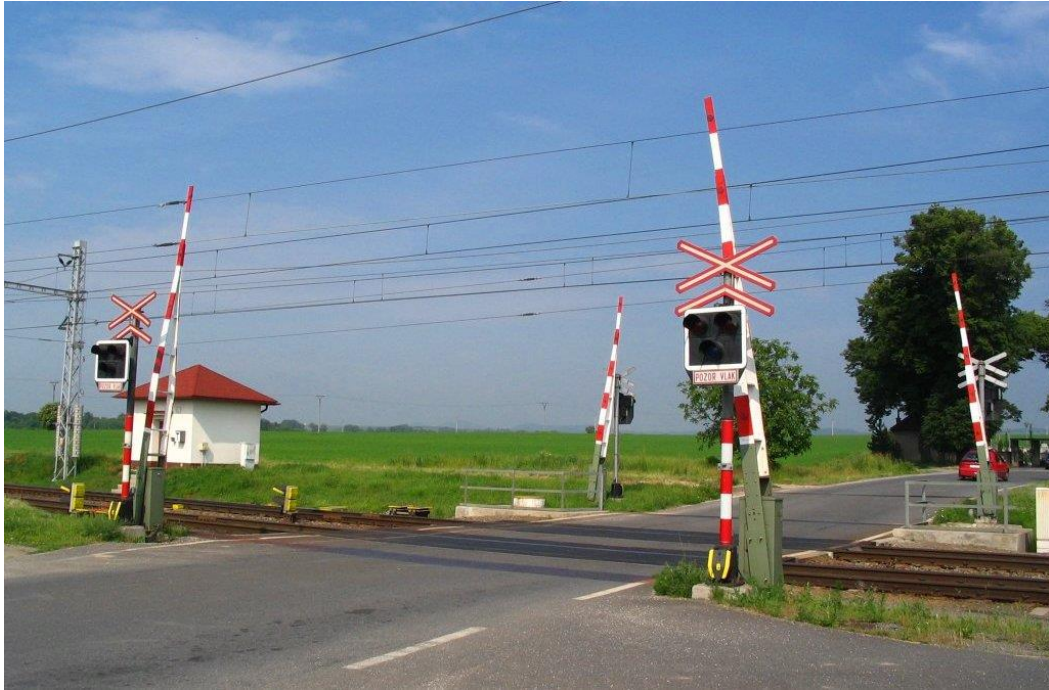
Obr. 15: Plně zabezpečený otevřený vícekolejný železniční přejezd vykazující varovný signál Zdroj: ŽelPage (2007), vlastní úprava
