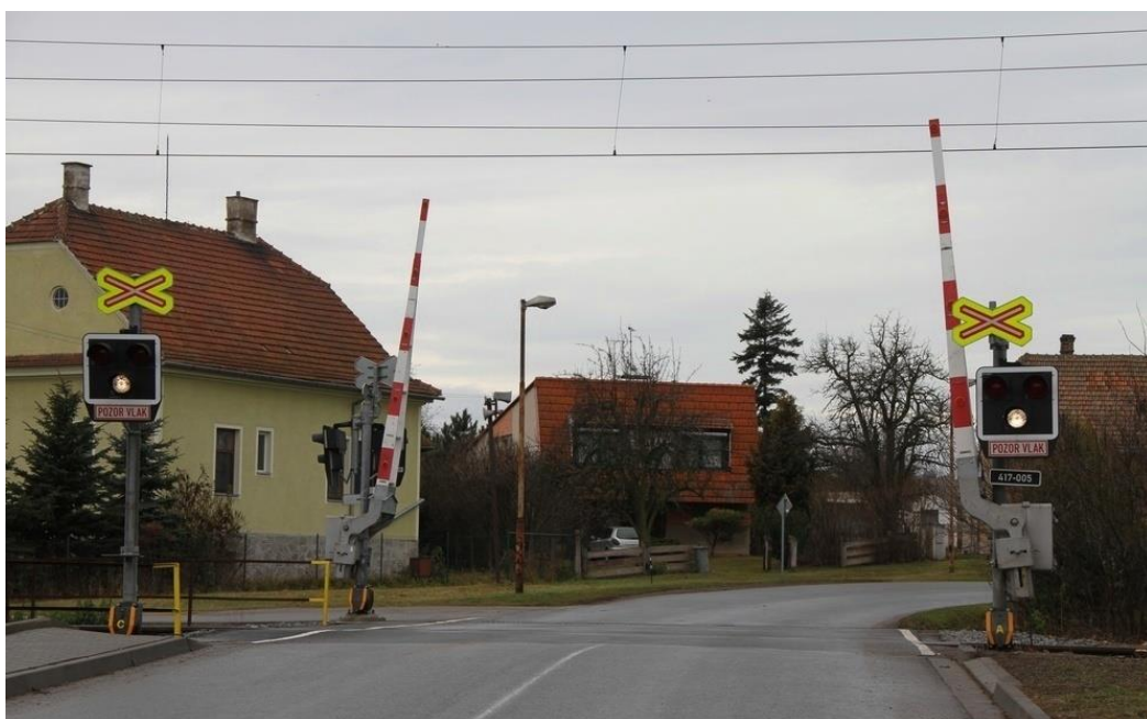
Obr. 13: Plně zabezpečený jednokolejný železniční přejezd vykazující pozitivní signál Zdroj: Randýsek (2019), vlastní úprava
