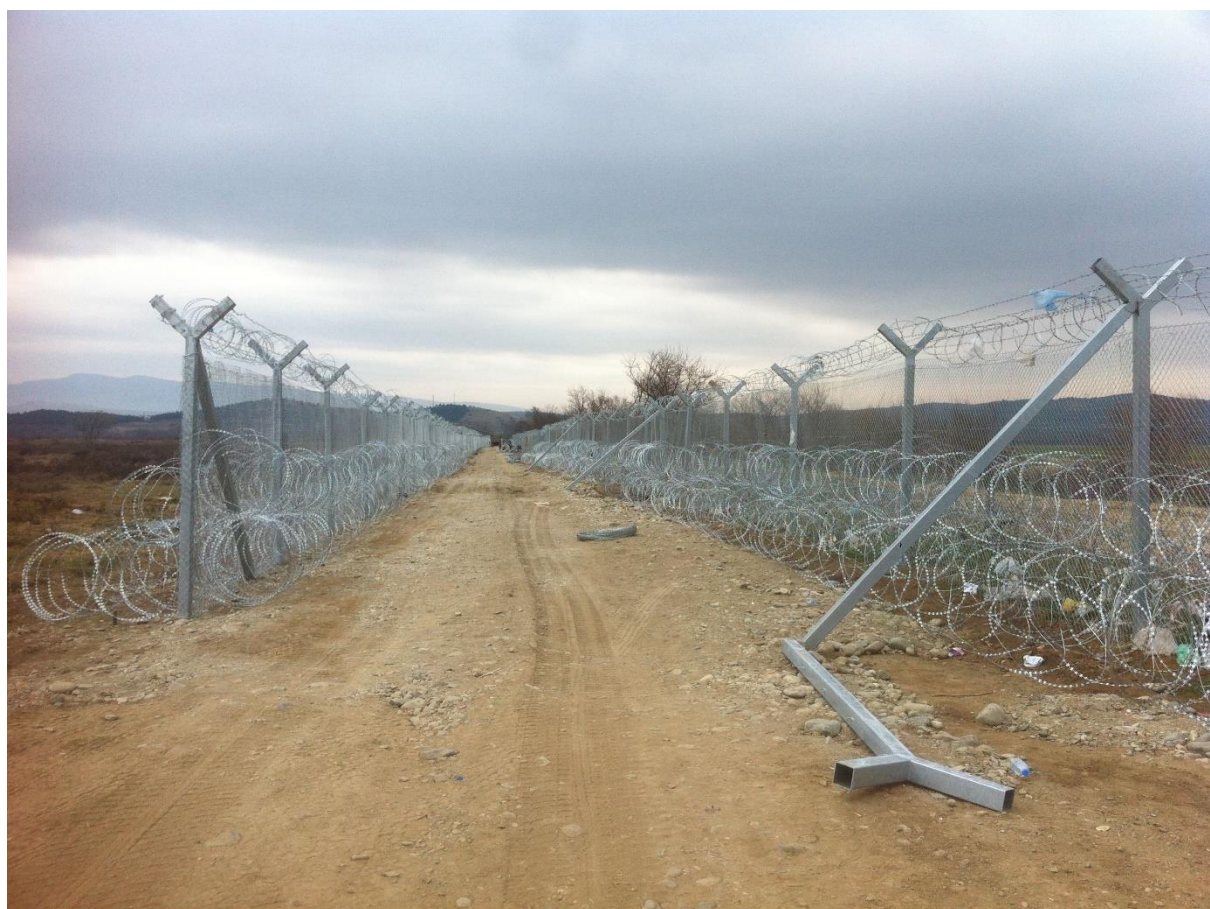
Obrázek 5 - Řecko makedonská hranice- stavba
