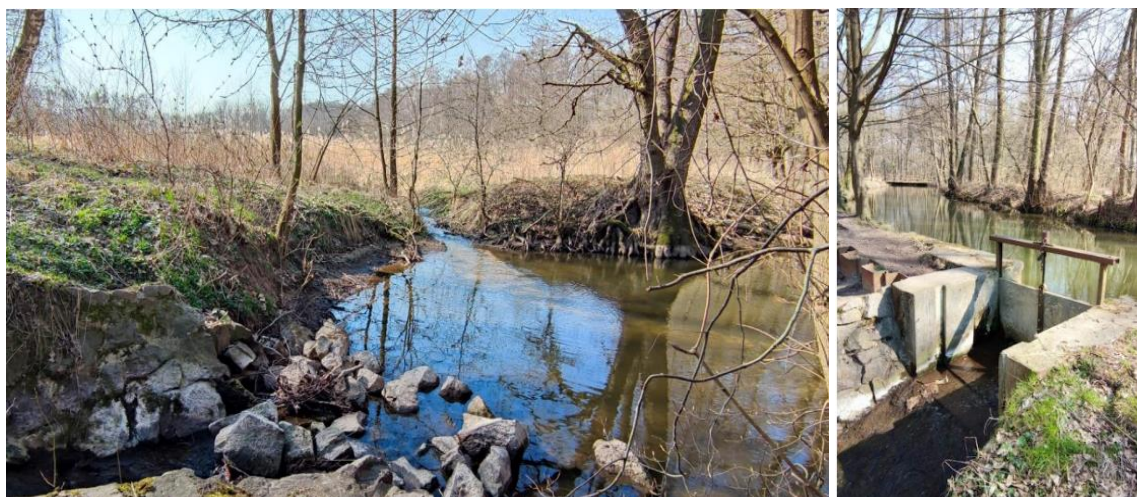
Obrázek 9: Antropogenně vytvořená břehová nátrž SZ od Nového zábranského rybníku a uzamykatelné stavidlo Zdroj: J. Štěpánek, listopad 2023
