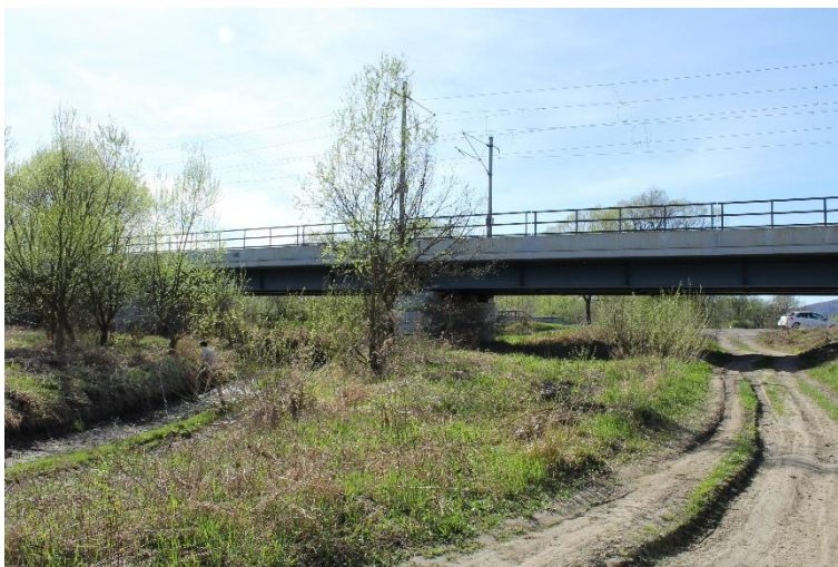
Obr. 13. Železniční most u obce Jeseník nad Odrou, DMK přítomen.
