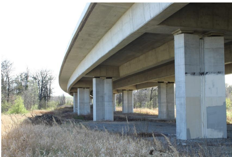
Obr. 11. Estakáda u obce Klimkovice (objekt č. 38), DMK přítomen.
