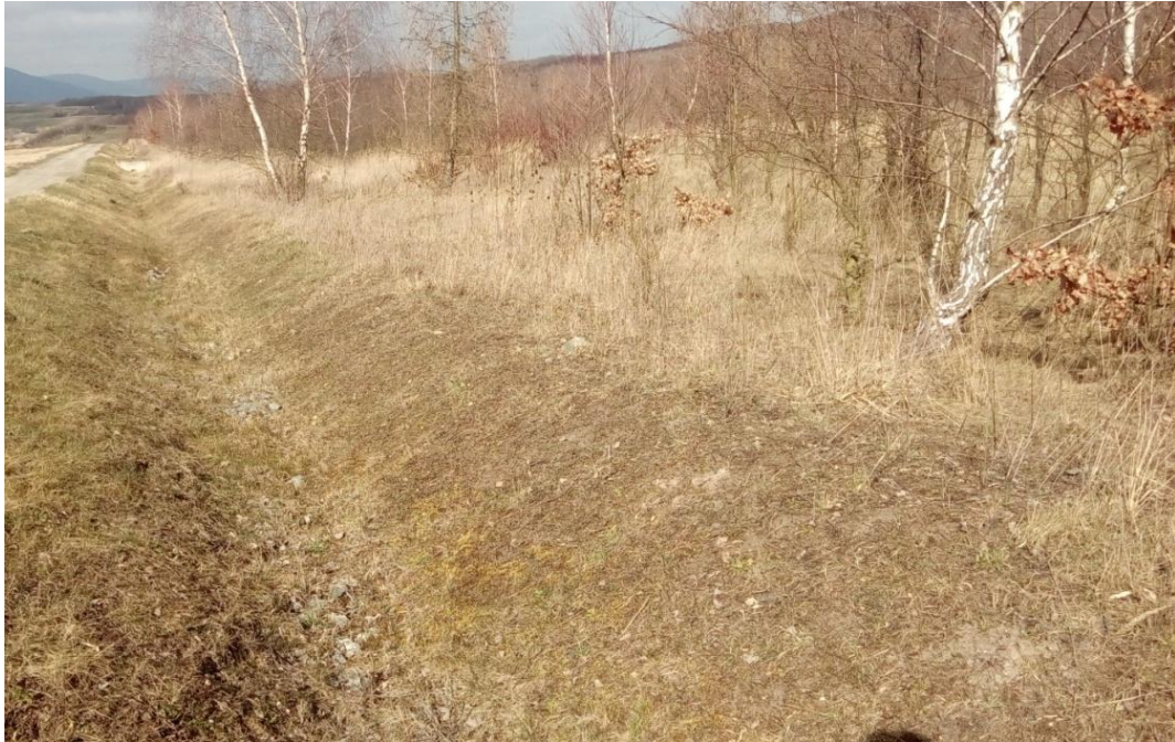
Obr. č. 54: Odvodňovací příkop na lokalitě Chabařovice
