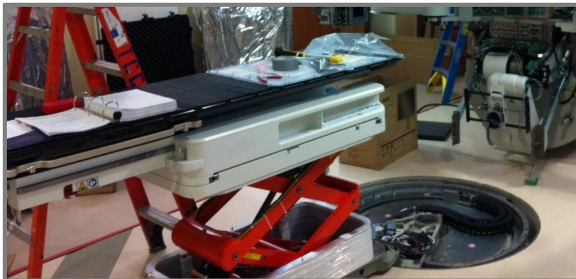
Obr. 2-29 – Detail na pantograf a základy lůžka [37]
