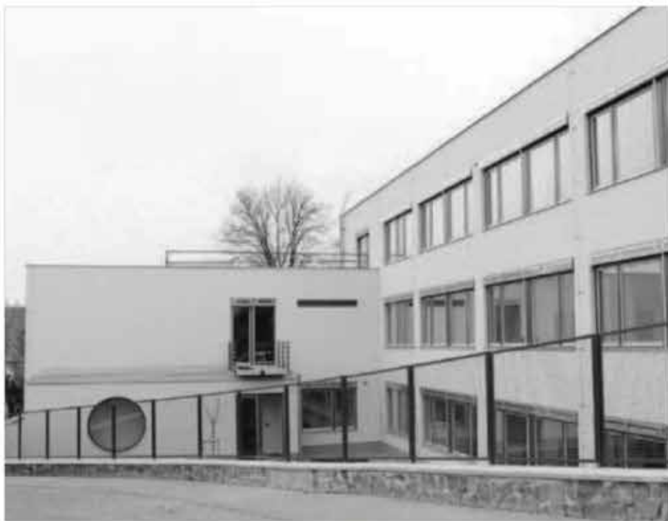
Exteriér rekonštruovaného Morávkov pavilónu, 2012
