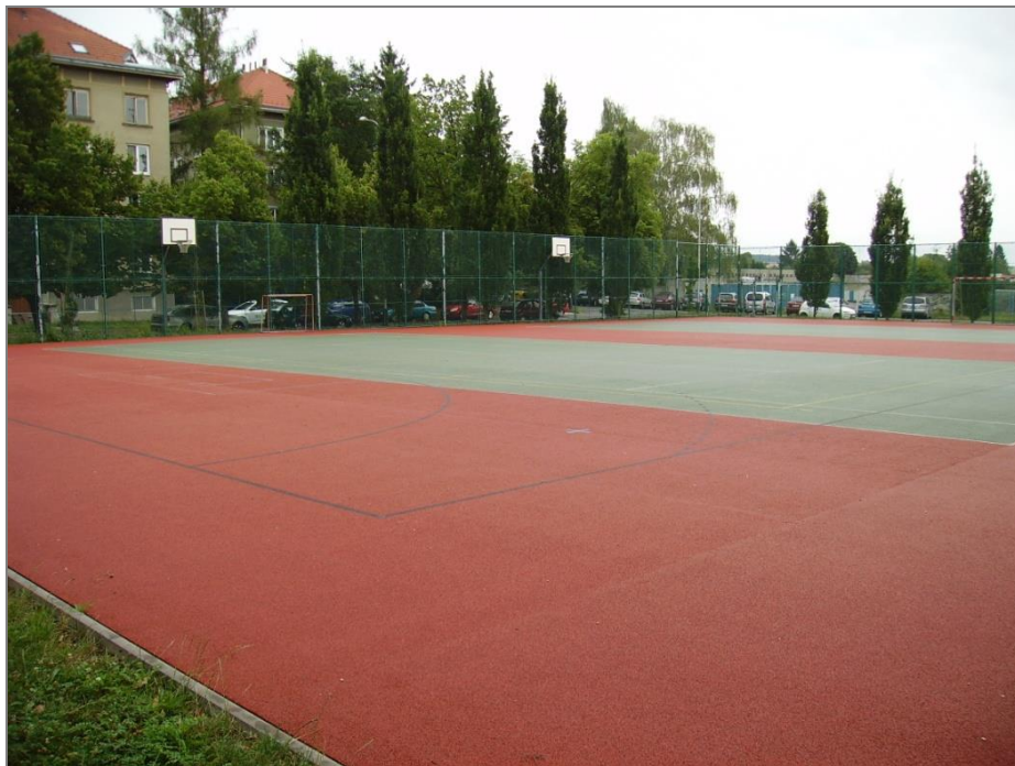
1 – ZŠ Želatovská, Přerov, víceúčelové hřiště
