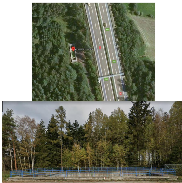
Obr. 4: Usazovací nádrže v blízkosti dálnice D1 („lapoly“)
