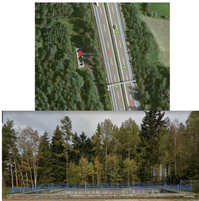
Obr. 4: Usazovací nádrže v blízkosti dálnice D1 („lapoly“)
