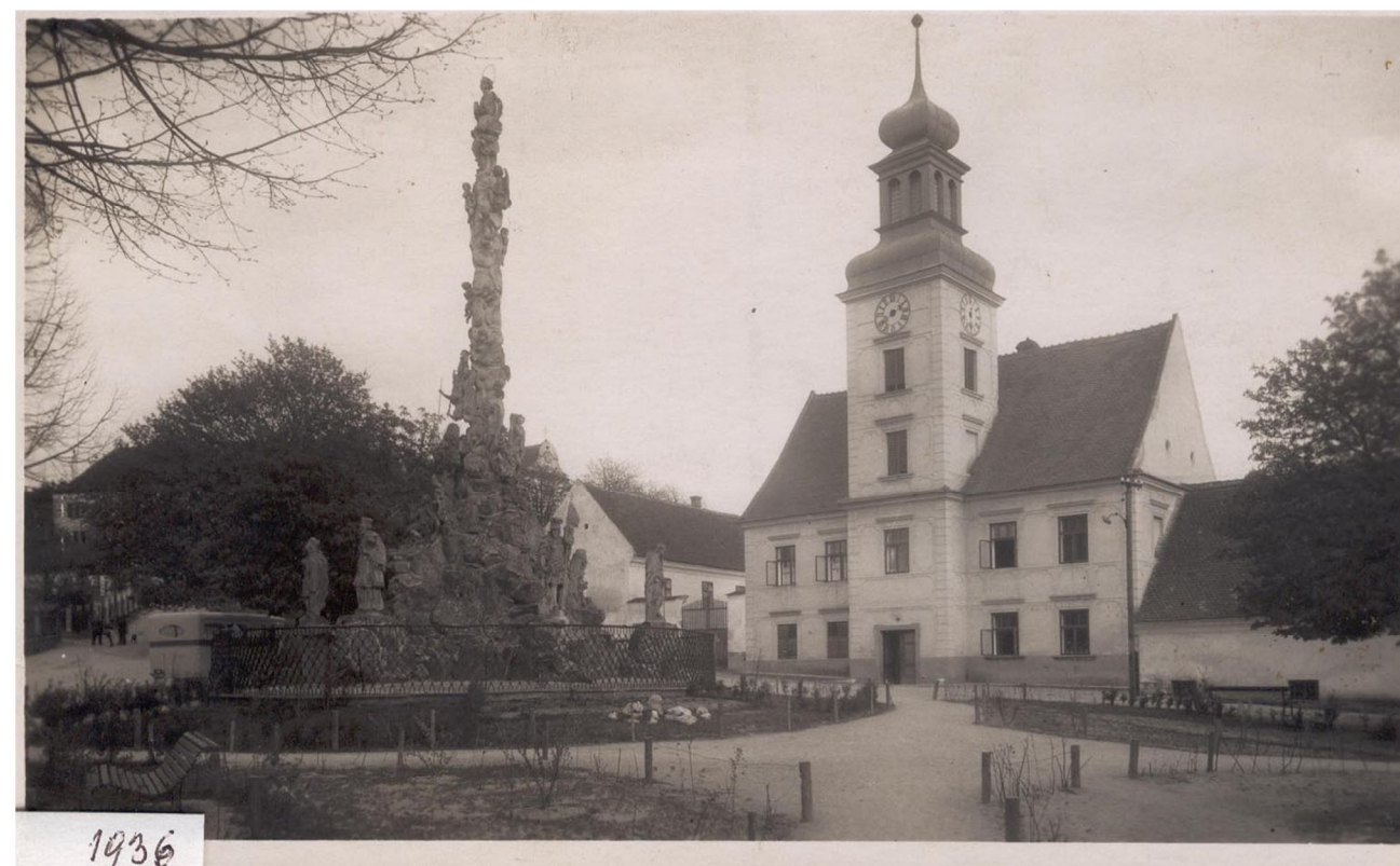
Obr. 25: Fotografie po výsadbě keřů a vytvoření ohraničených ploch z roku 1936 (archiv Lomnice)
