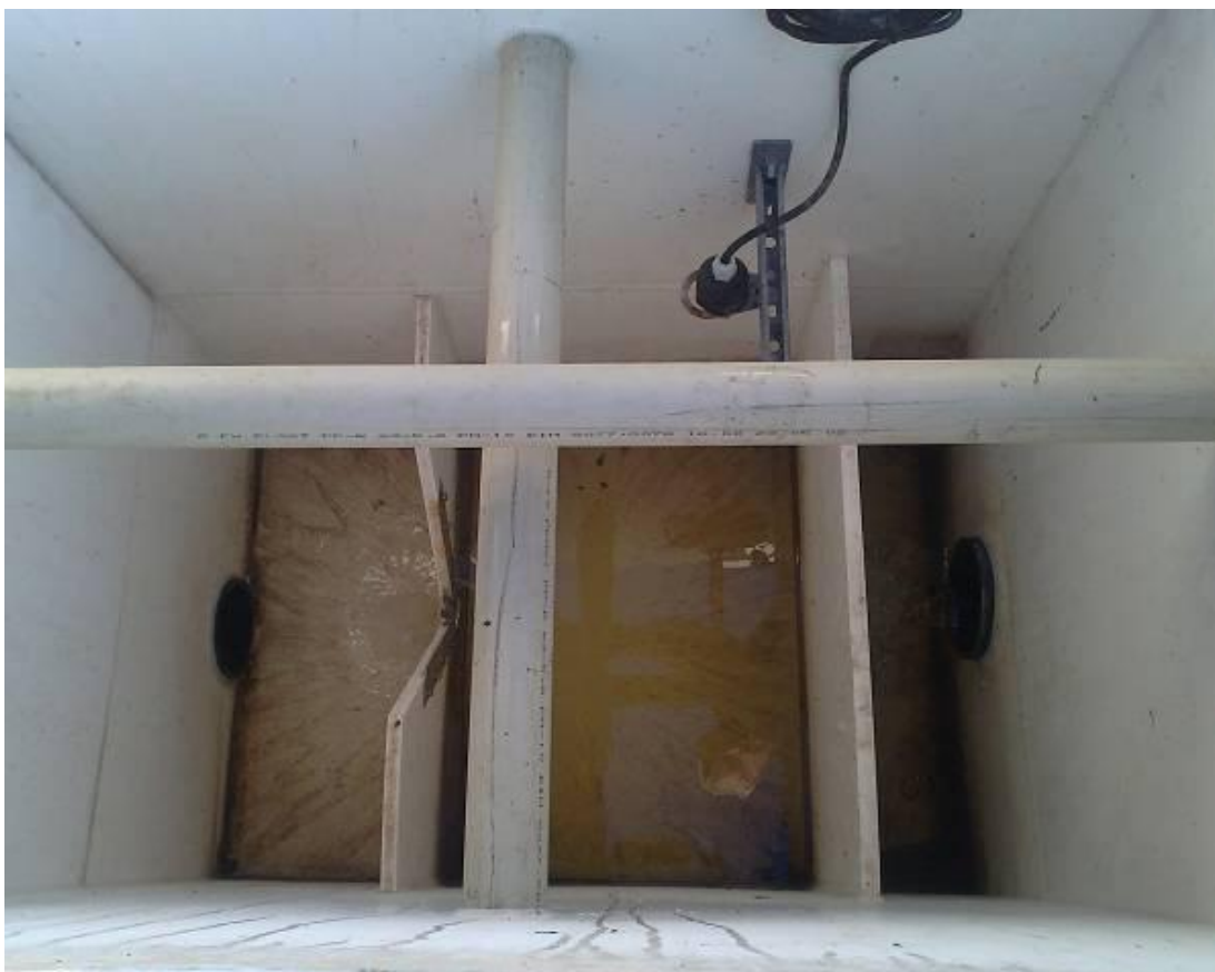
Foto č. 10: Měrný Thomsnův objekt s „V“ přepadem, zdroj vlastní
