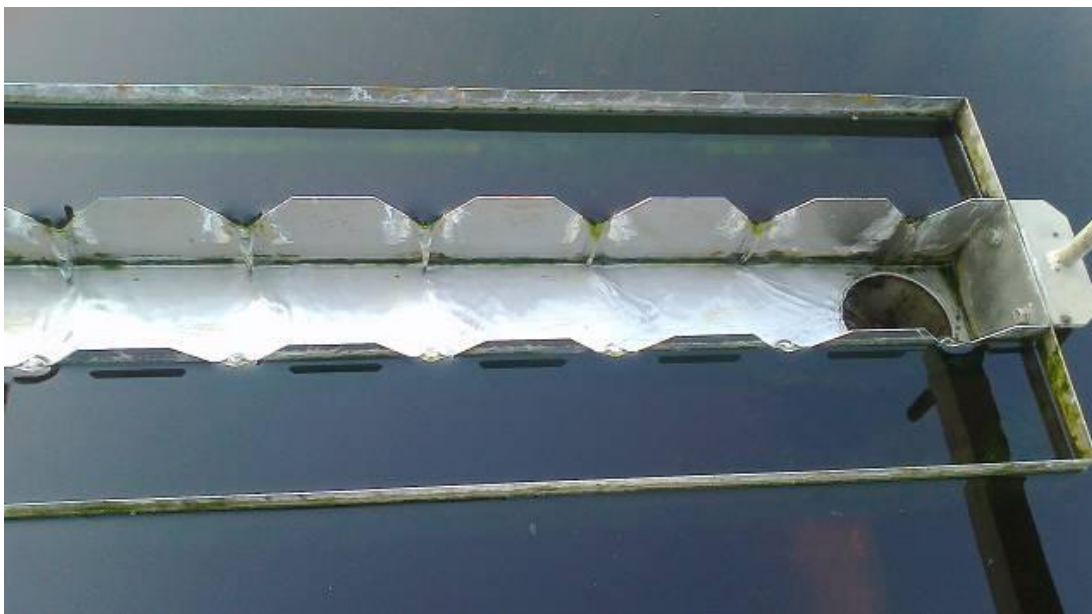
Foto č. 13: Odtokový žlab, zdroj vlastní
