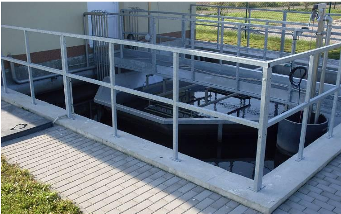
Foto č. 4: Biologický reaktor ČOV Semtěš, zdroj vlastní
