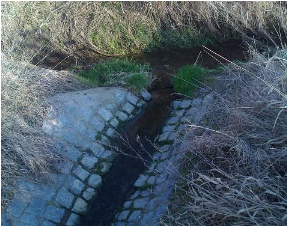
Foto č. 15: Odtok z ČOV do recipientu- potok Bumbálka, zdroj vlastní
