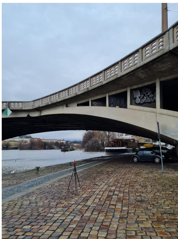
Obr. 13: Stanoviště č. 5 (Náplavka pod Jiráskovým mostem).
