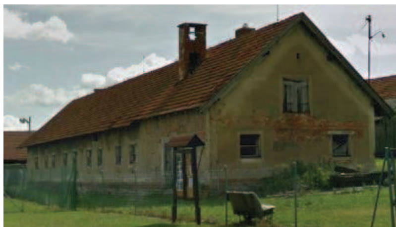
Obr. 29 Foto budovy B (zdroj: http://maps.google.com )
