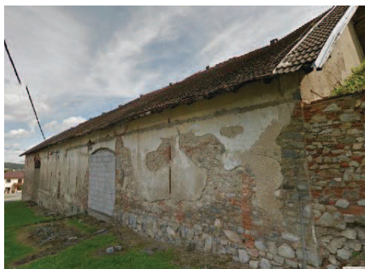
Obr. 28 Foto budovy A (zdroj: http://maps.google.com )
