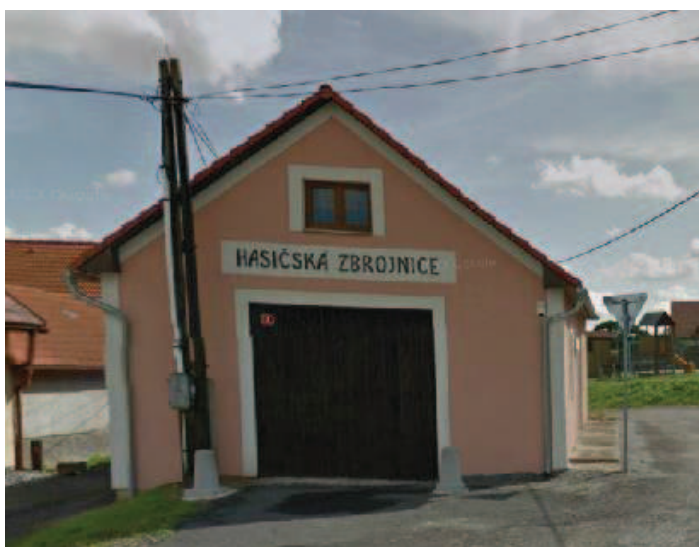
Obr. 36 Foto budovy H (zdroj: http://maps.google.com )
