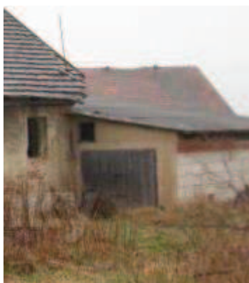
Obr. 35 Foto budovy G (zdroj: http://www.mmreality.cz )
