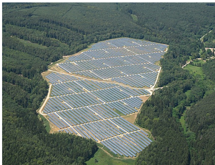
Obrázek 8. Fotovoltaická elektrárna Ralsko Ra 1 [19]
