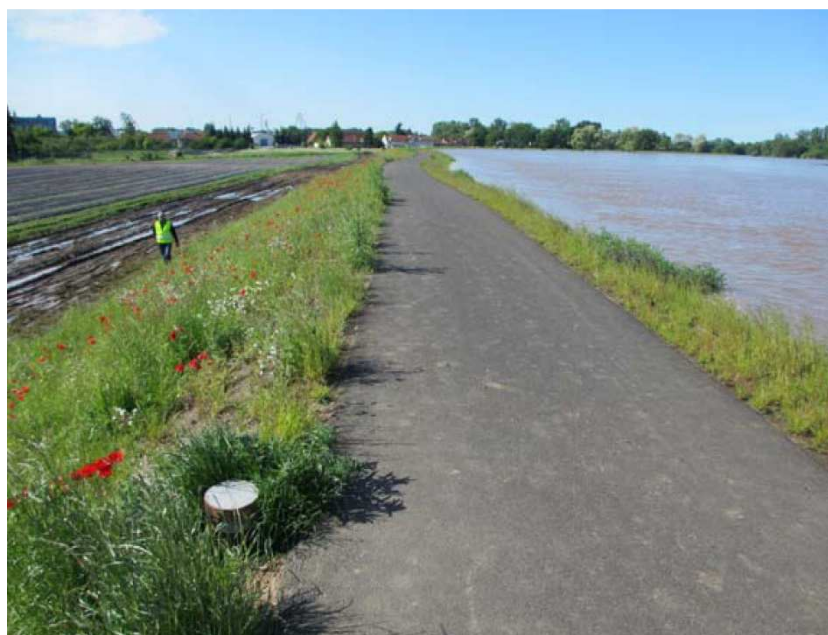
Obr. 7 Ochranná hráz v lokalitě Mlazice při povodni 2013 (Povodí Labe 2014)
