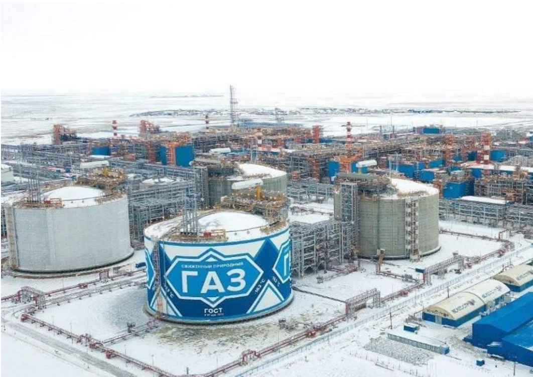
LNG Cisterns of South Tambey / Yamal LNG Plant
