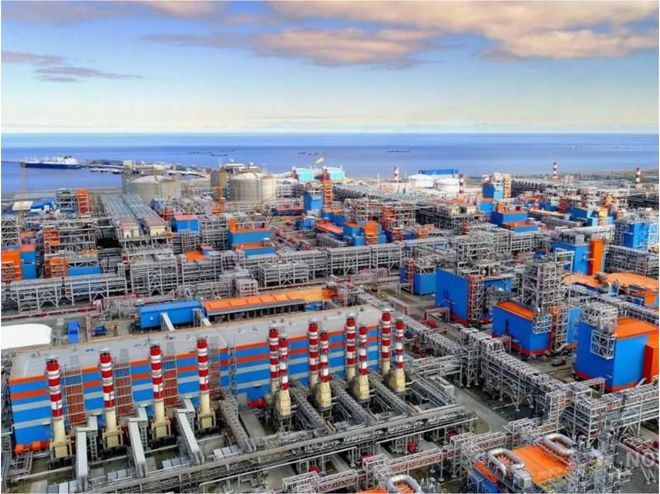
South Tanbey LNG – the biggest LNG plant up the Arctic circle / Summer – Polar Day
