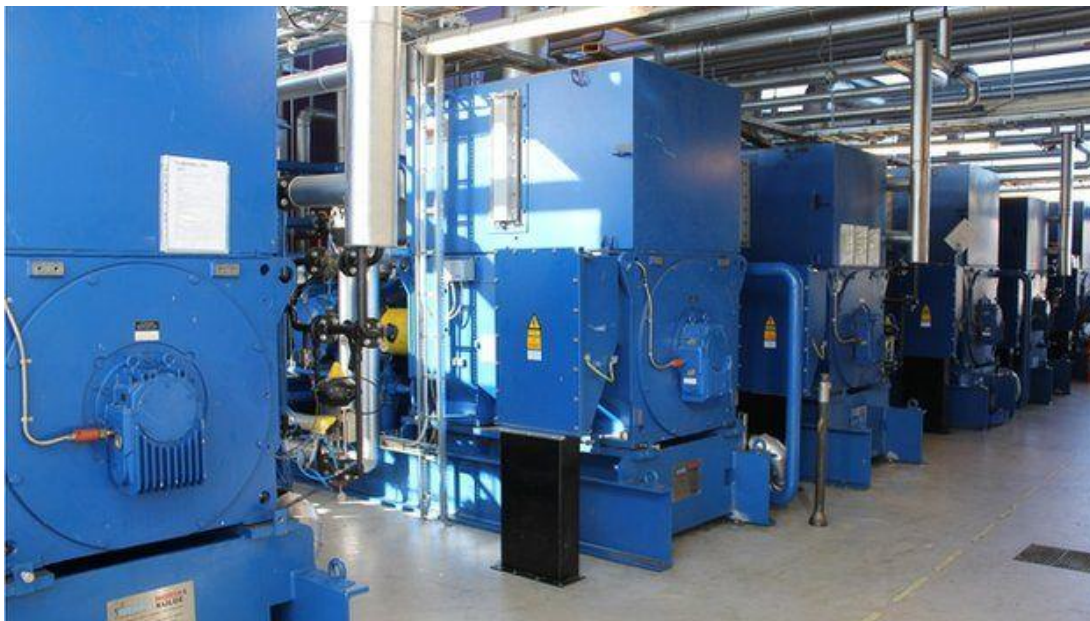
Obrázok 30 Strojovňa tepelných čerpadiel [70]
