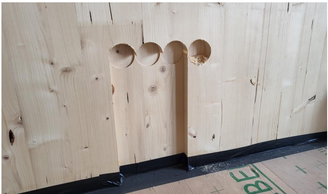
Obrázek 8 Příprava elektro-instalace zhotovená na CNC stroji (autor)
