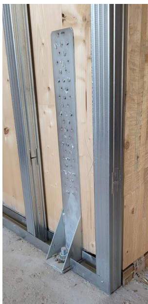
Obrázek 11 Detail použití tahové kotvy (autor)
