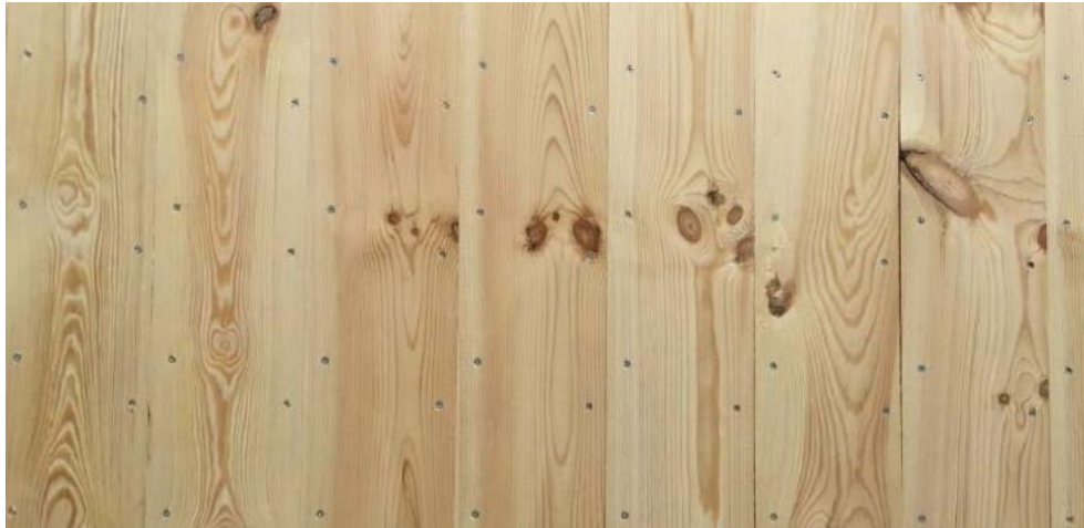
Obrázek 3 Nepohledová strana CLT spojovaného vrty (Dek, 2024)
