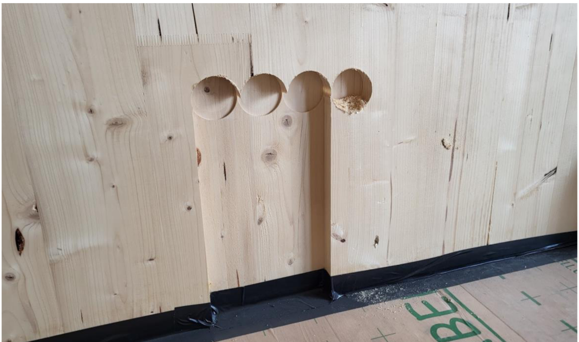
Obrázek 8 Příprava elektro-instalace zhotovená na CNC stroji (autor)
