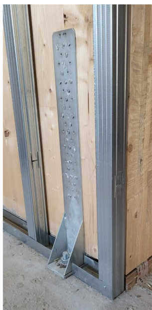
Obrázek 11 Detail použití tahové kotvy (autor)
