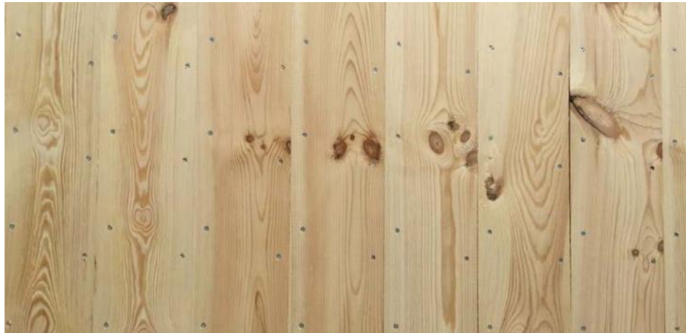
Obrázek 3 Nepohledová strana CLT spojovaného vruty (Dek, 2024)
