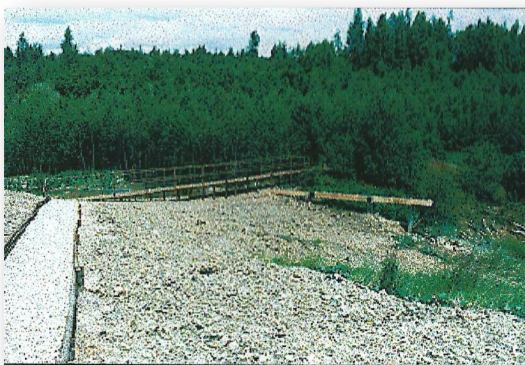
Obrázek 26 - Původní dřevěný mostek přes Ježkův vodopád, ENKI, s.r.o., 1997
