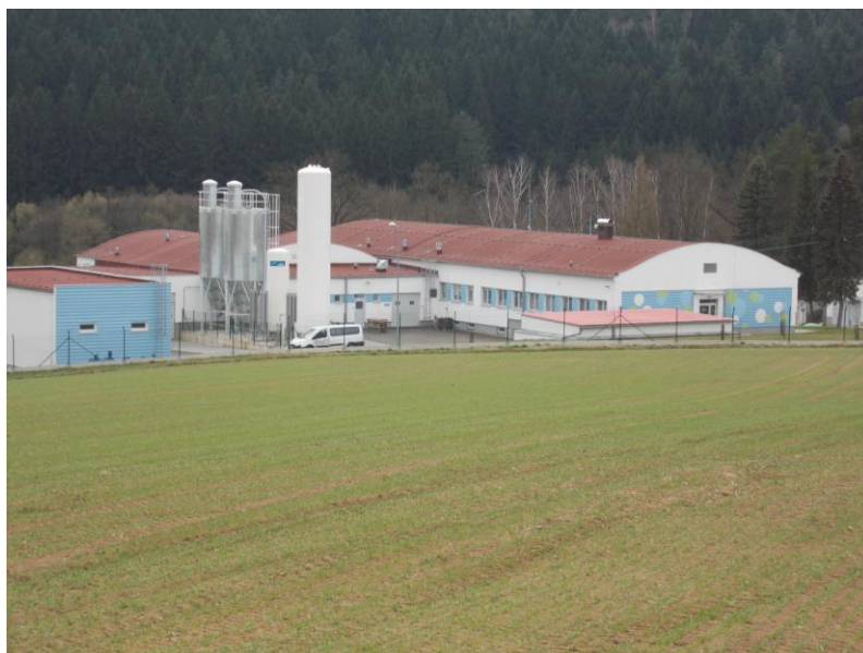
Obr. č. 8: Úpravna vody Mostiště (Zdroj: autorka práce)
