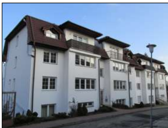
Obr. č. 2 Pohled na stavbu
