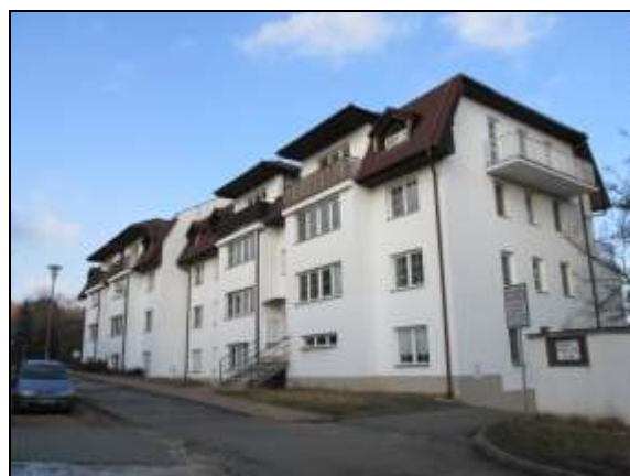
Obr. č. 3 Pohled na stavbu
