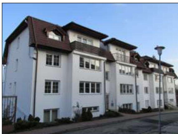
Obr. č. 2 Pohled na stavbu
