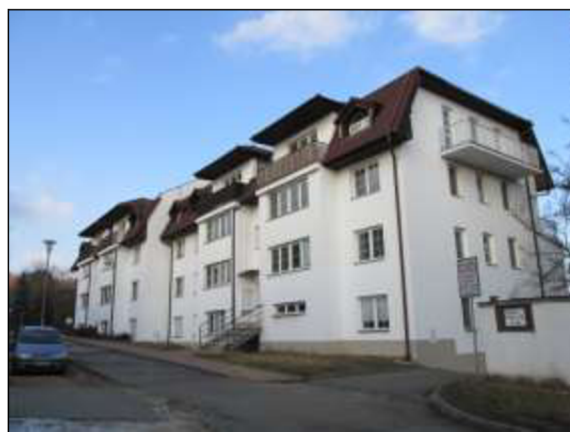
Obr. č. 3 Pohled na stavbu
