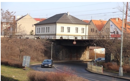
Obr. č.3: Most před rekonstrukcí
