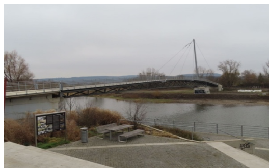
Obr. č.10: Lávka po rekonstrukci
