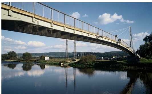
Obr.č.9: Lávka před rekonstrukcí
