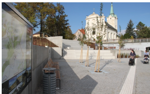
Obr. č.12: Místo u řeky po rekonstrukci
