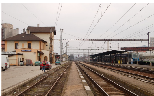
Obr. č.13: Nádraží před rekonstrukcí
