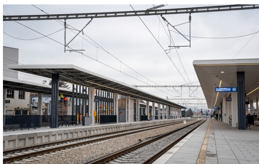
Obr. č.14: Nádraží po rekonstrukci
