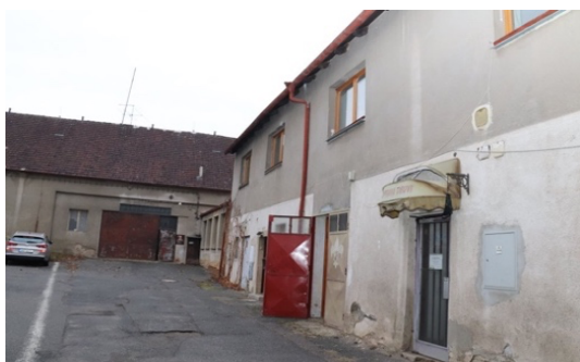
Obr. č.7: Kul. centrum před rekonstrukcí
