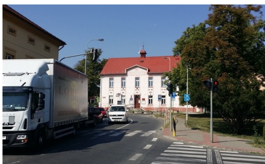
Obr.č.5: Křižovatka před rekonstrukcí
